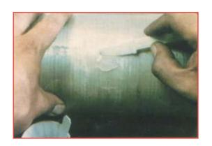
Wenn zusätzlicher Schutz gefordert ist, bringen Sie ein Stück Glasfasergewebe auf den beschädigten Bereich auf. Dieses sollte etwas grösser sein als die Beschädigung. Tragen Sie eine dünne Schicht Harz über dem Gewebe auf, wobei darauf zu achten ist, dass es völlig bedeckt wird.
